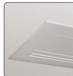
Leinwand in abgehängter Decke installiert
